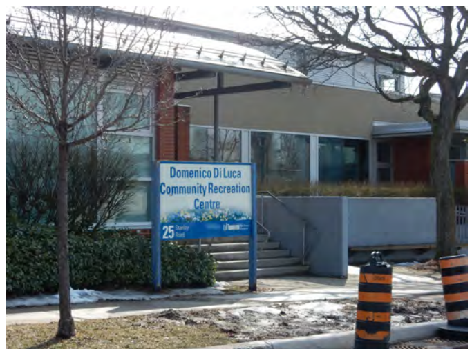
Domenico Di Luca Community Recreation Centre.
