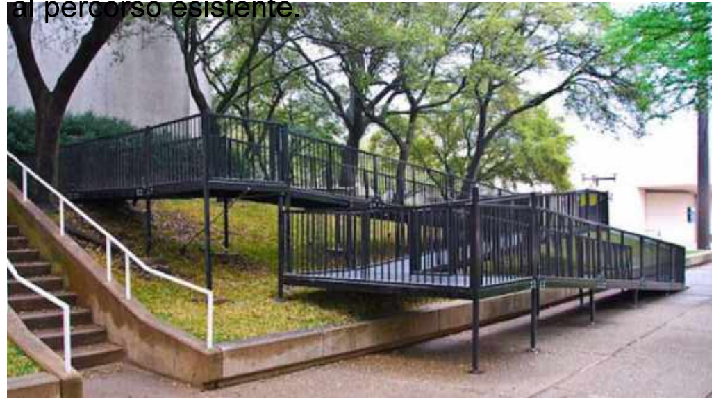
Esempio di una rampa di inversione di marcia Fonte: http://www.portawalk.com/tas_guidelines.html
