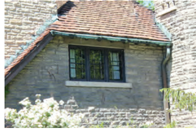
The stone masonry (ERA 2017).
