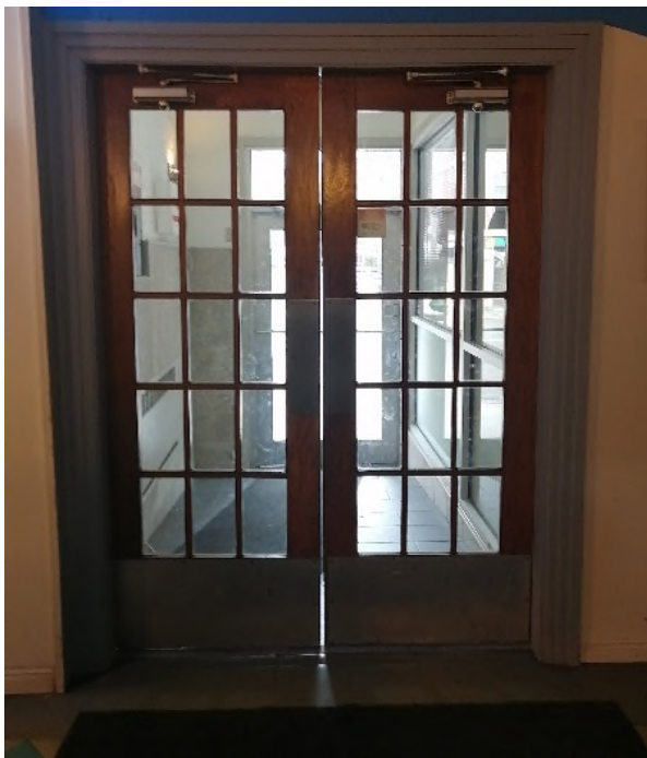
Entrance Vestibule (ERA, 2022).
