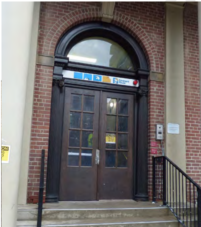
23. West entrance door (ERA, December 2025)
