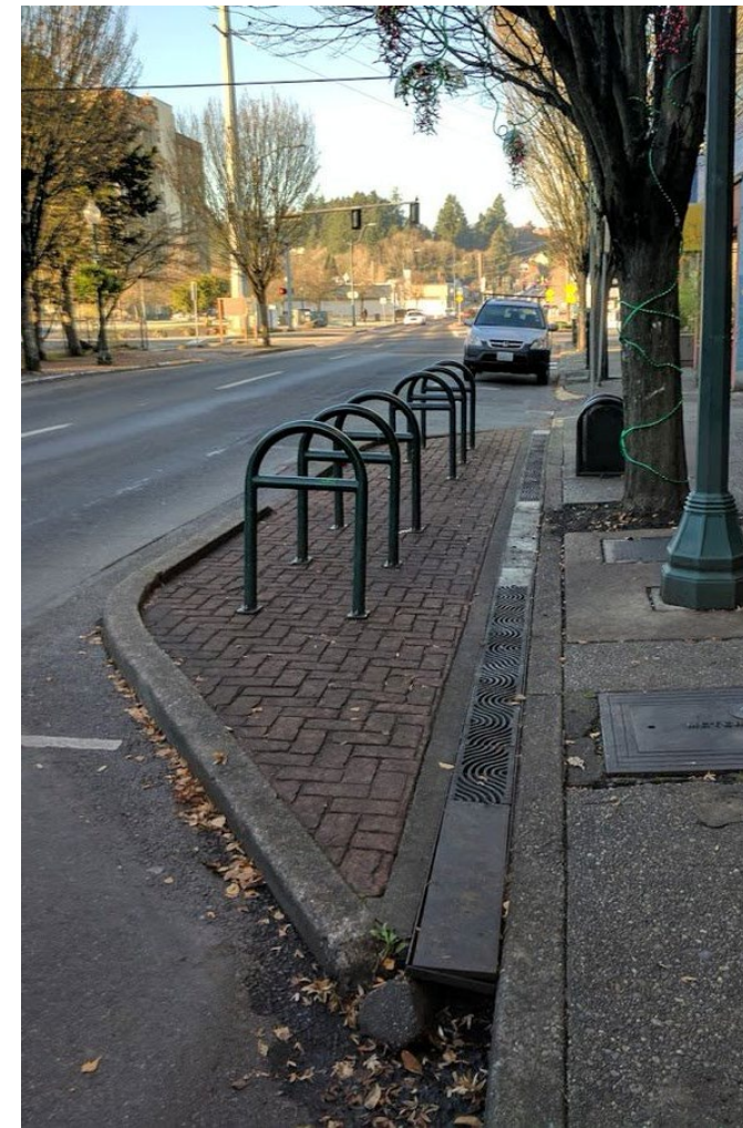
路缘伸出区安装自行车停放架
