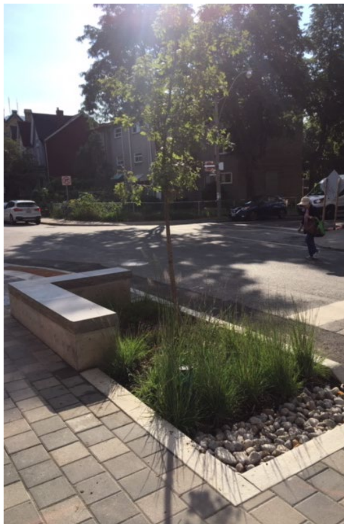
路緣延伸區栽種綠植、安裝路邊椅
